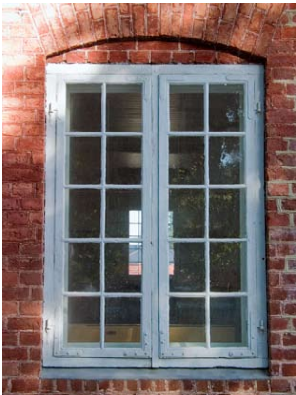
Over: Vindu mot nord sett utenfra. Legg merke til hjørnejern med avrundede avslutninger.
