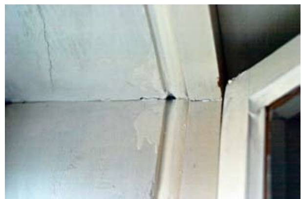
Over: Midtposten er opprinnelig. Profiling tilsvarende Snekkerverkstedet, men midtpostens snitt er rektangulær i grunnform her. Snekkerverkstedets har skrådde sider. Under: Karmens opprinnelige profilerte avslutning sees bak utforing.
