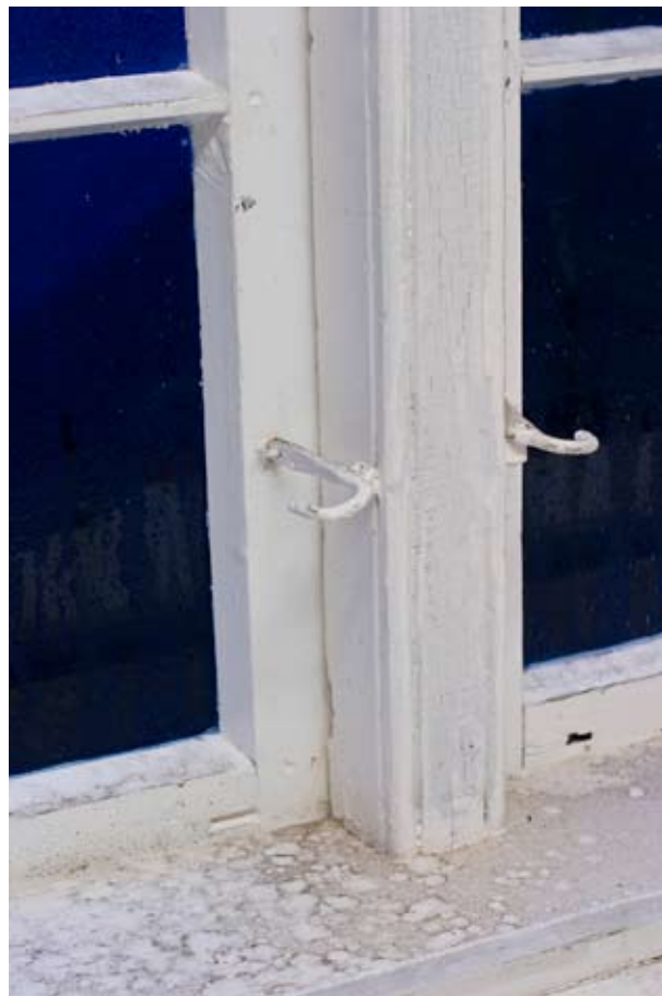
Over: Midtpost med hasper. Sannsynligvis originalt alt sammen.
