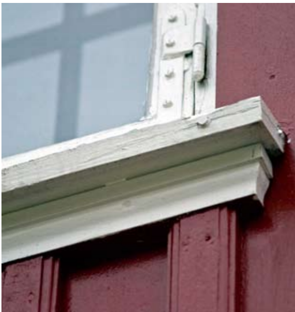
Over: Midtposten er opprinnelig. Profiling tilsvarende Snekkerverkstedet, men midtpostens snitt er rektangulær i grunnform her. Snekkerverkstedets har skrådde sider. Under: Karmens opprinnelige profilerte avslutning sees bak utforing.
