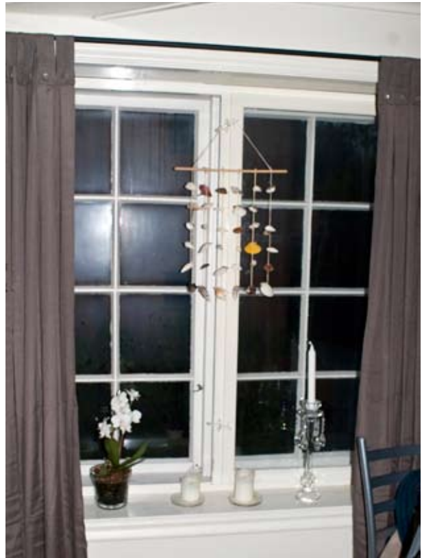
Vinduet sett innenfra. Varevinduet og utforing pga nyere innv. platekledning skjuler detaljene til det bevarte vinduet.
