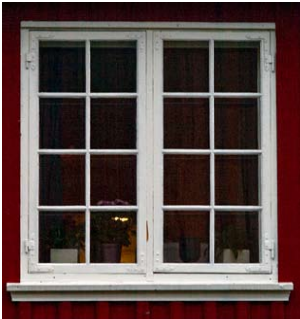
Over: vinduet sett utenfra. Alt panel og listverk er moderne. Eldre jern, men ikke opprinnelige.
