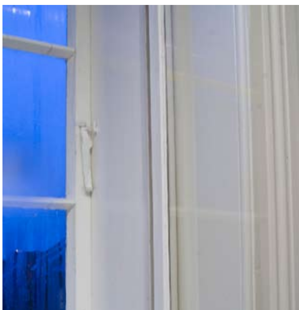
Under: Stormkrok av 17/1800-talls type. Sannsynligvis gjenbruk eller overskuddslager.
