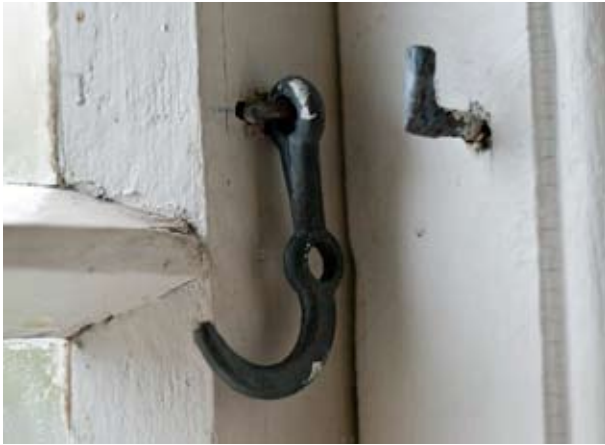
Over: Haspe som neppe er original. Skrudd i med øyekrok.
