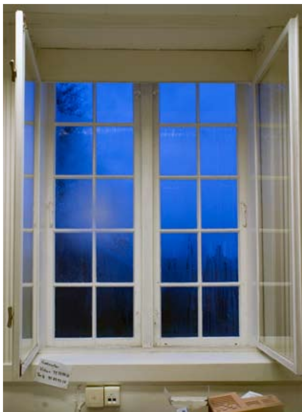
Under: Vindu sett fra innsiden.
