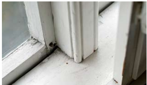
Over: Midtposten er opprinnelig. Profiling tilsvarende Snekkerverkstedet, men midtpostens snitt er rektangulær i grunnform her. Snekkerverkstedets har skrådde sider. Under: Karmens opprinnelige profilerte avslutning sees bak utforing.
